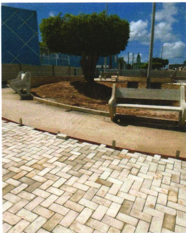
ITEM POSTES DE CONCRETO E PISO INTERTRAVADOS
