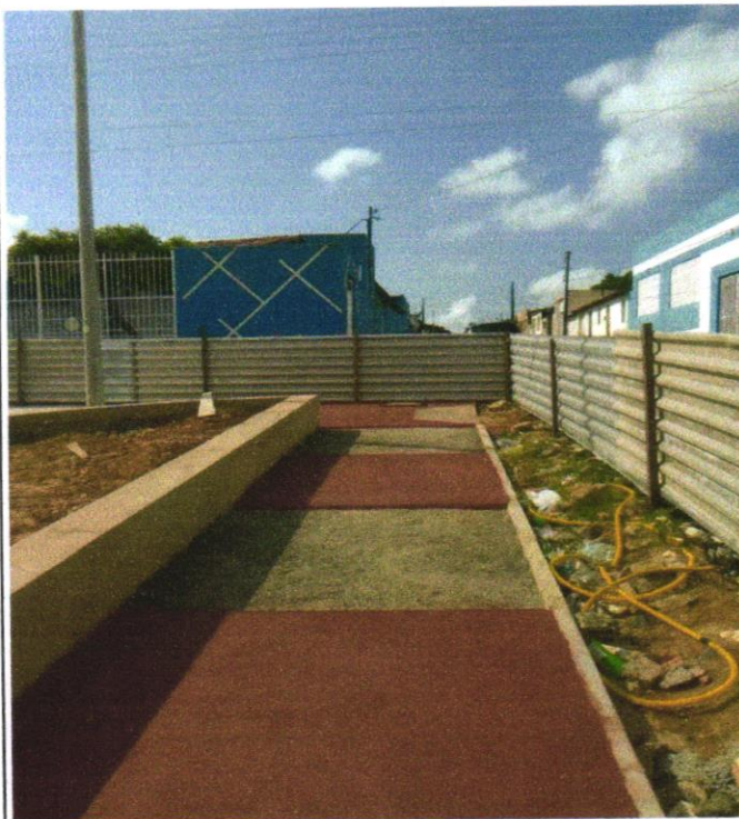
ITEM CONCRETAGEM COM PIGMENTO
