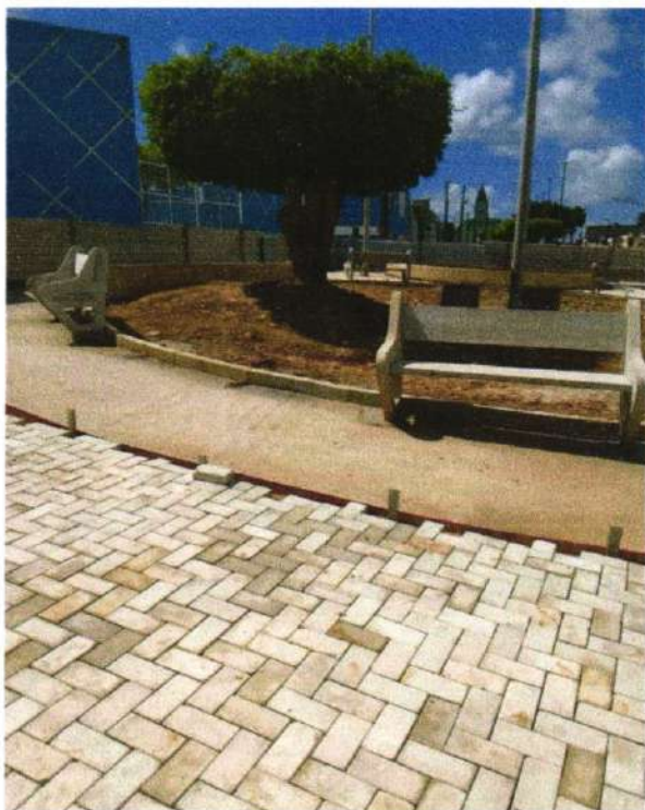
ITEM POSTES DE CONCRETO E PISO INTERTRAVADOS
