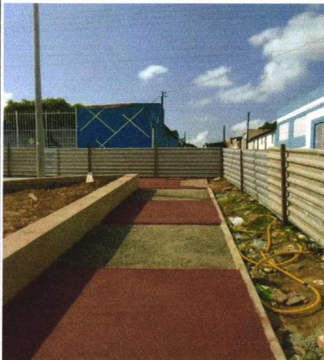
ITEM CONCRETAGEM COM PIGMENTO
